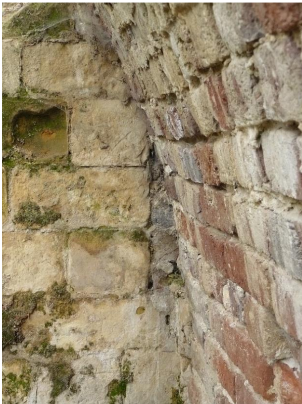
Afbeelding 4.4: blokvertanding van de mergelstenen muur met de bakstenen steunmuur tussen de steekkelders B en D.
