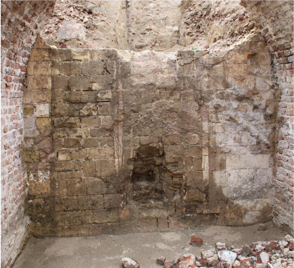
Afbeelding 4.26: aanzicht steekkelder E vanuit de centrale kelder A.
