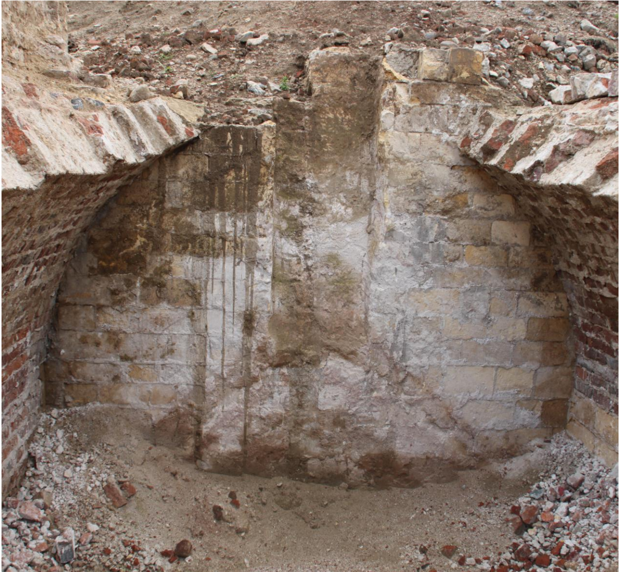
Afbeelding 4.29: aanzicht steekkelder F vanuit de centrale kelder A.
