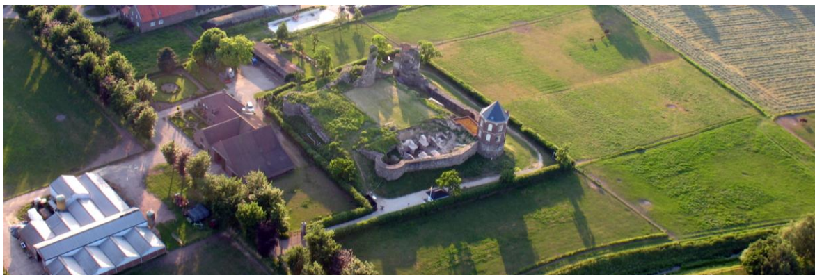
Afbeelding 6.2: Luchtfoto van kasteel Montfort vanuit het zuidoosten, met de ontgraven kelders van de oostvleugel.
