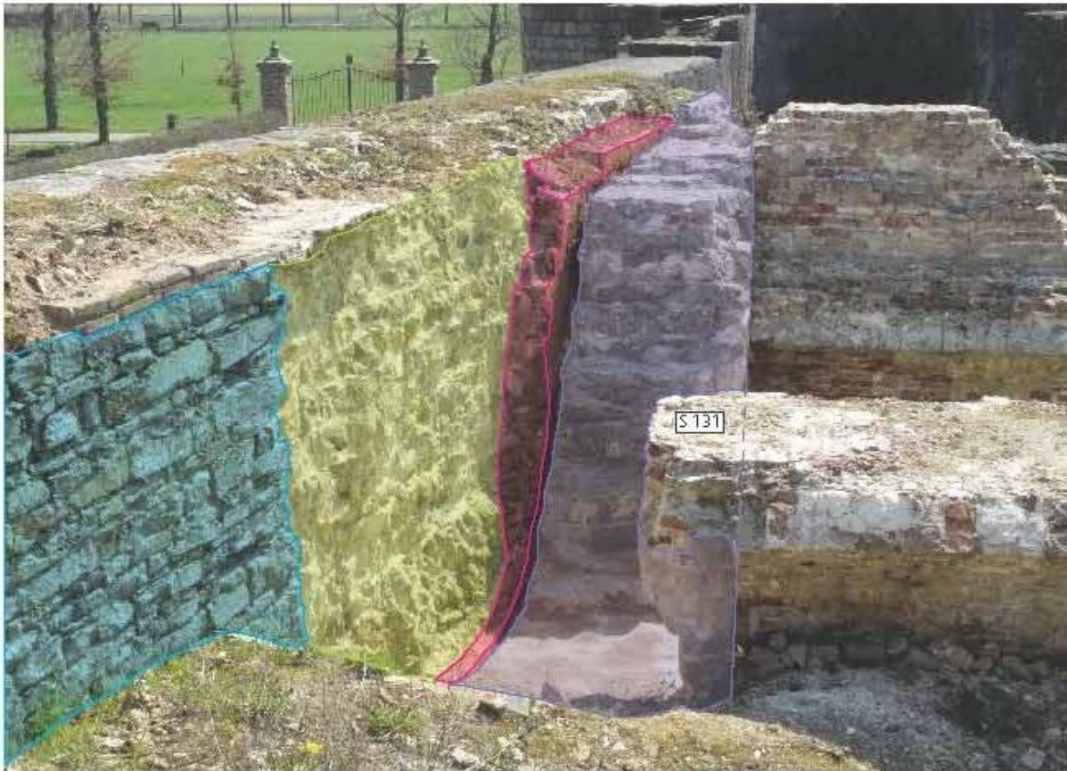
Afbeelding 4.9: Oostelijke kasteelmuur richting het zuiden.
