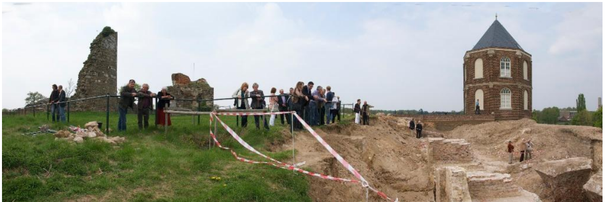
Afbeelding 6.3: Het hoogteverschil tussen het huidige boventerrein (links) en de oorspronkelijke begane grond van de oostvleugel (rechts) is op deze foto goed te zien.
