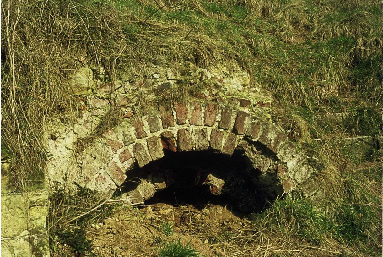
Afbeelding 2.40: foto van de bovenzijde van de toegang tot de oostelijke kelders vanuit de trappenhal uit 1975. Hieruit valt af te leiden dat de trappenhal toen nog maar gedeeltelijk vrijgegraven was.
