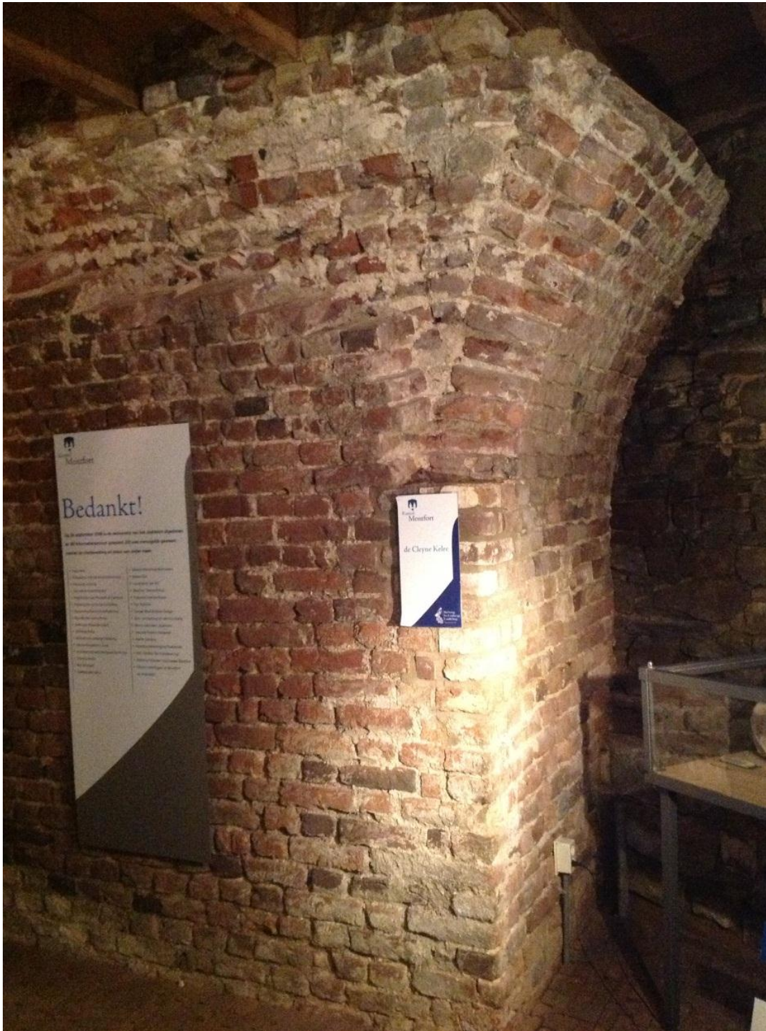
Afbeelding 4.33: Identieke steunmuur in het gerestaureerde gedeelte.
