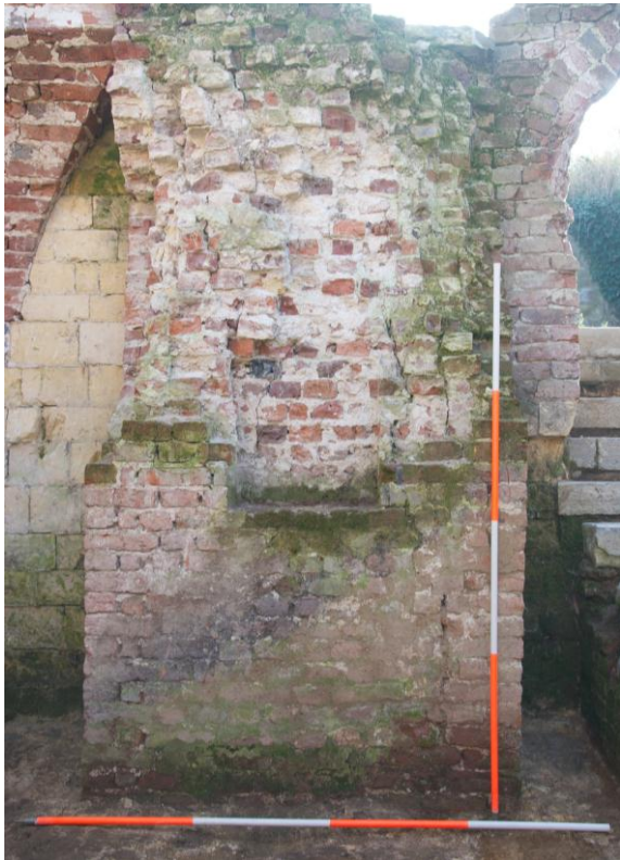
Afbeelding 4.16: steunbeer voor trap vanuit trappenhal naar begane grond oostvleugel (S86).
