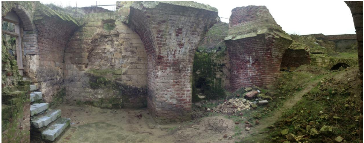
Afbeelding 6.4: overzicht van de binnenplaatwand van het zuidelijk deel van de kelders.
