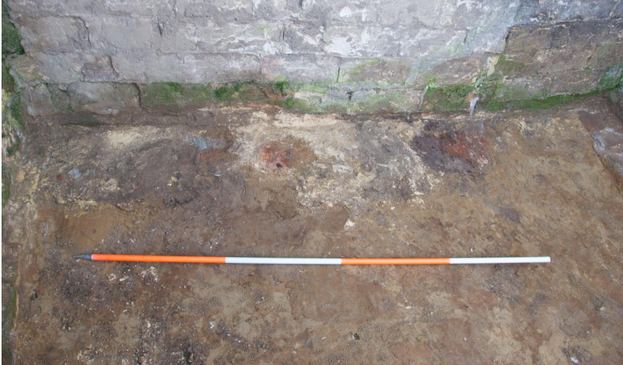
Afbeelding 5.11: Brandsporen op de vleilaag en de onderkant van de mergelstenen muren.
