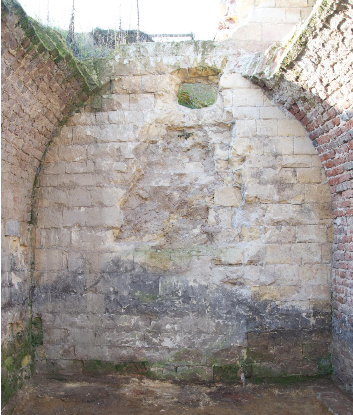
Afbeelding 4.22: aanzicht steekkelder C vanuit de centrale kelder A.
