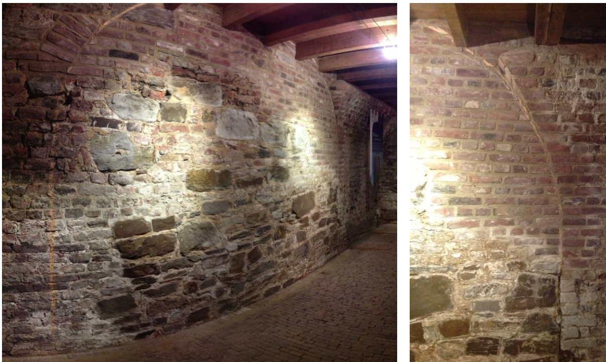
Afbeelding 5.14: Dichtgezette doorgang naar het zuidelijke deel van de kelders onder de oostvleugel. De contour van decentrale gang is met krijt op de muur getekend.
