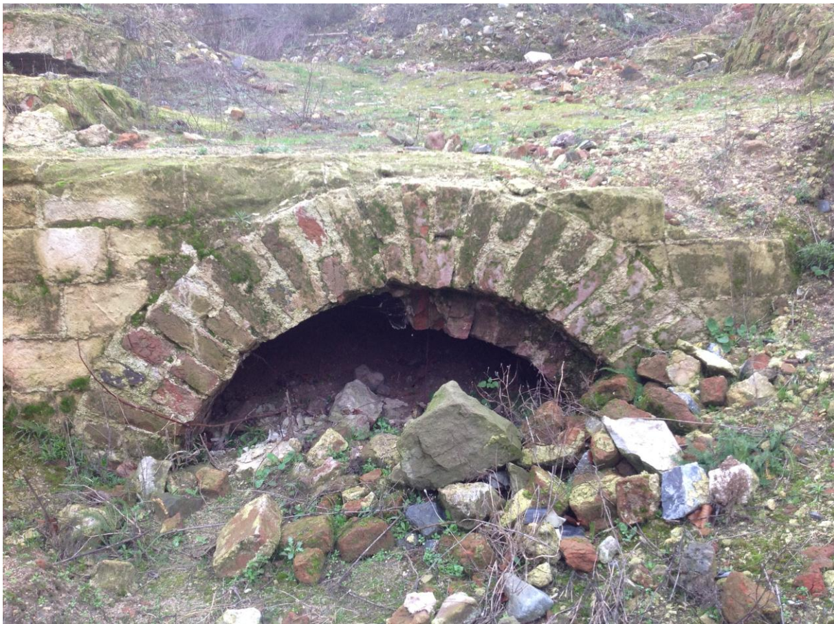
Afbeelding 4.6: Doorgang door de mergelstenen dwarsmuur.
