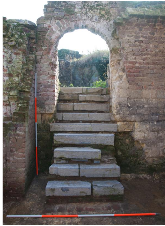
Afbeelding 4.17: natuurstenen trap vanuit kelder naar trappenhal bij zuid-oosttoren (S83).
