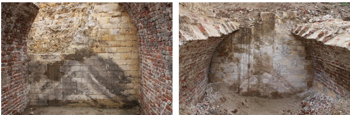
Afbeelding 5.13: Sporen van de storthopen in de steekkelders D en G, direct onder de ventilatieschachten.
