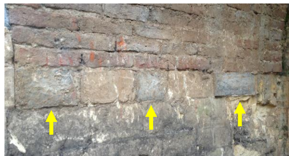
Afbeelding 4.18: natuurstenen blokjes in de mergelstenen dwarsmuur (S125), direct onder de geboorte van de gewelven van de steekkelders B en C.
