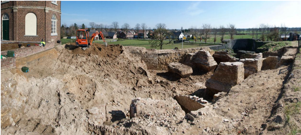
Afbeelding 3.10: Deze foto geeft ongeveer het niveau van vlak 2 aan. Op de voorgrond de steunmuren van de gewelven van de begane grond aan binnenpleinzijde.
