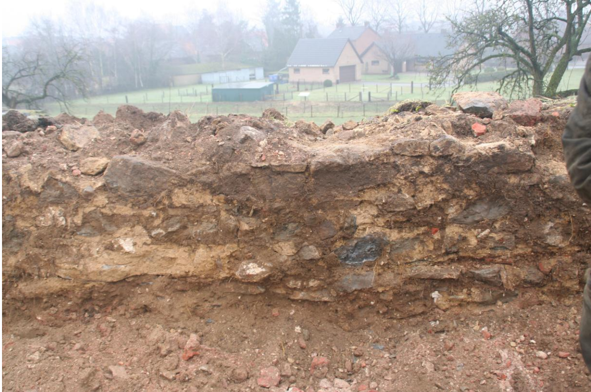
Afbeelding 3.5: Intact gedeelte van de waarschijnlijk rond 1850 gerealiseerde primitieve keermuur.
