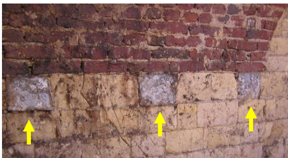
Afbeelding 4.18: natuurstenen blokjes in de mergelstenen dwarsmuur (S125), direct onder de geboorte van de gewelven van de steekkelders B en C.
